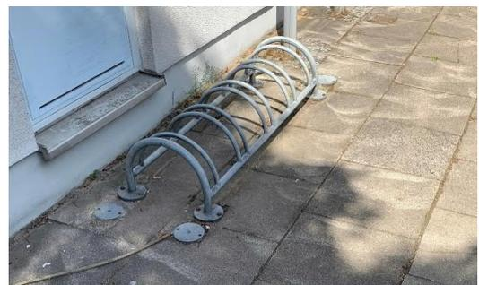
Abbildung 12: Beispielfotos von Anlehnbügel und Vorderradhaltern
