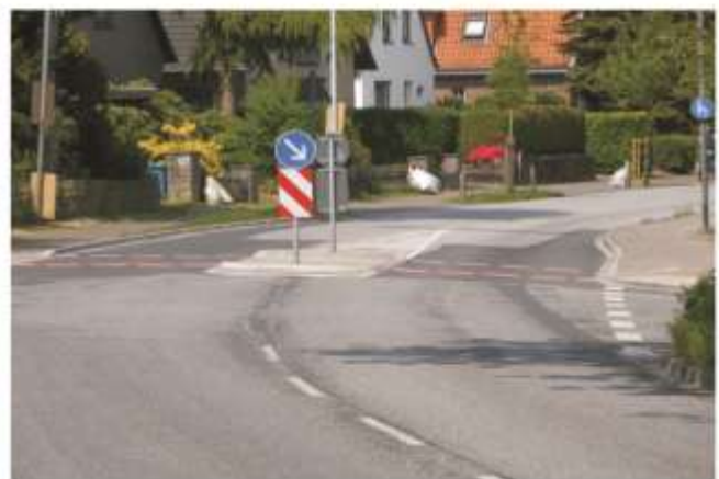
Bünningstedter Str.: Fahrbahnteiler ersetzt Lichtsignalanlage. Eine einfache und komfortable Überquerungsmöglichkeit mit Aufmerksamkeitseffekt
