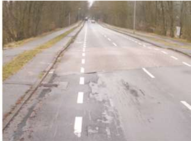
Hagener Allee Süd: Neue Qualitäten für den Radverkehr durch Ersatz von zu schmalen Radwegen durch Schutzstreifen
