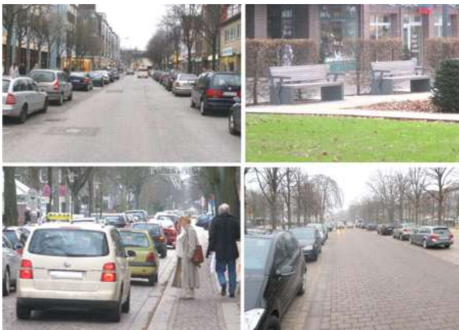
Hamburger Str. und Manhagener Allee (Zentrum): Kfz-orientierte Straßenraumgestaltung mit fehlenden Qualitäten für Fußgänger und Radfahrer
