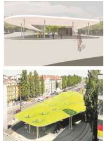
Beispiele für moderne ÖPNV-Verknüpfungsanlagen
