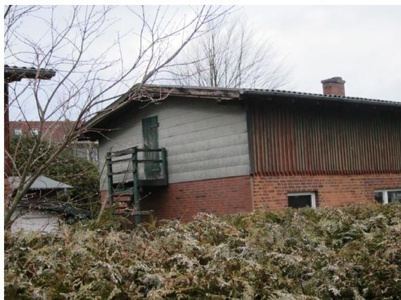
Faserzementplatten als Ersatz für die senkrechte Holzverschalung im Obergeschoss an der Giebelseite sowie bautechnische Mängel im Ortgangbereich
